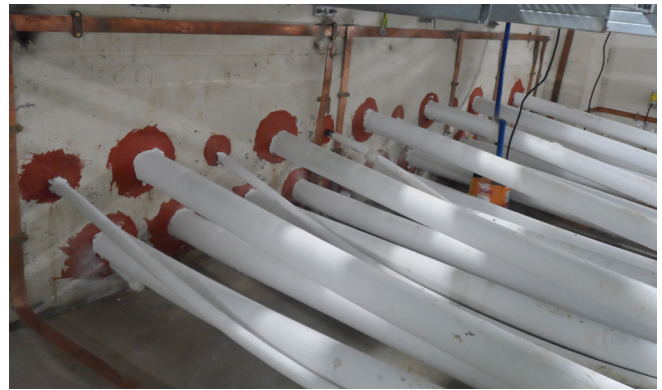
Solución de sellado de masilla para fugas
