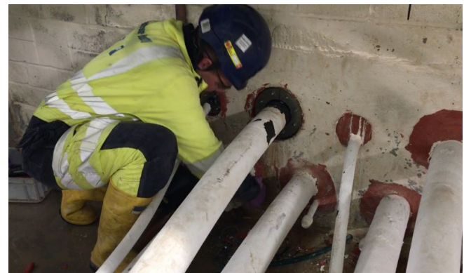
Instalación de HRD 188-1G-1/97
