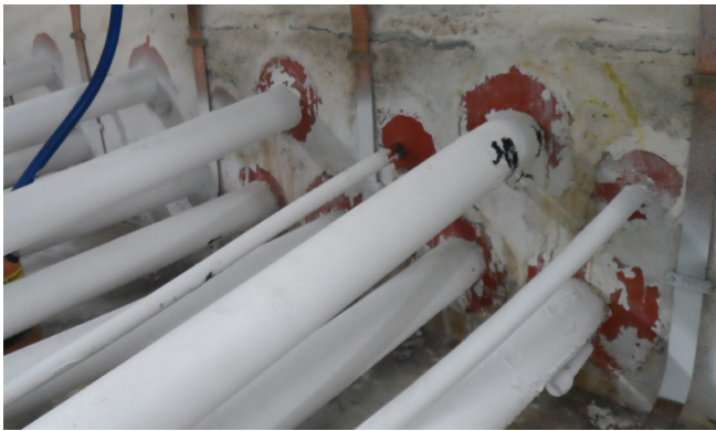
Solución de sellado con masilla para fugas
