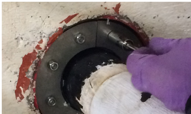
Instalación de HRD 188-1G-1/97
