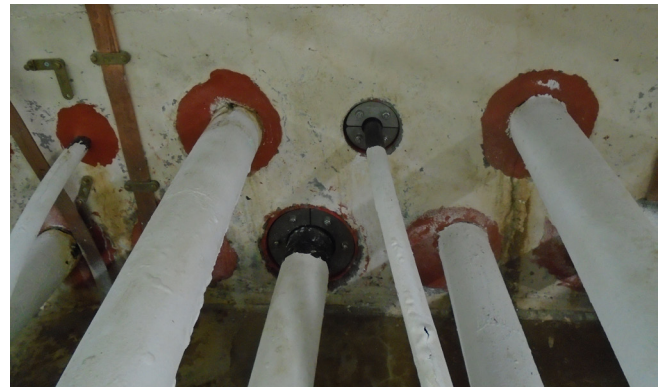
Instalación de prueba de 2 sellos
